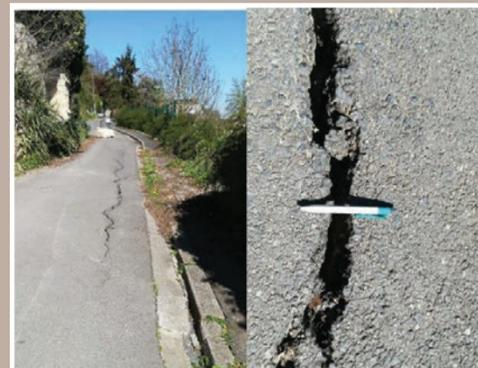
La Rue Simone Le Danois présente une fissure récente au niveau de la voirie. On note l'absence d'un glissement du talus en contre bas de la rue. On note également la présence d'un collecteur dans l'axe de la fissure. Ce collecteur correspond vraisemblablement au projet de réseau d'assainissement pour lequel FONDASOL est intervenu sur site en 2015 et 2017.
