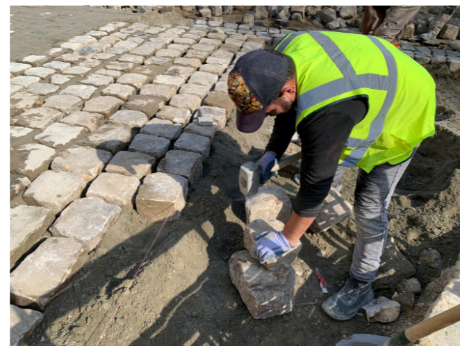
Pose de pavés anciens Napoléon par les agents de l'entreprise DESPIERRE
