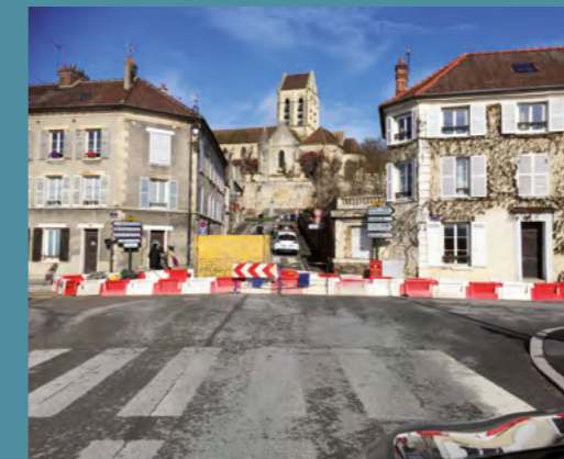
▲ Emprise des travaux : de la rue de Paris jusqu'au parc Van Gogh
