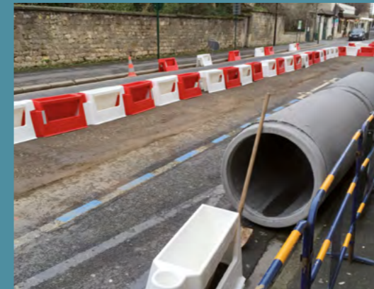
▲ Collecteur béton de 800mm
