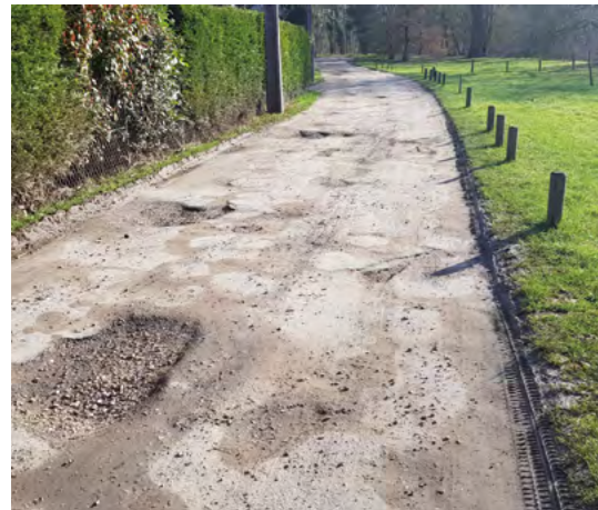
▲ Réparations de la rue de Bellerive
